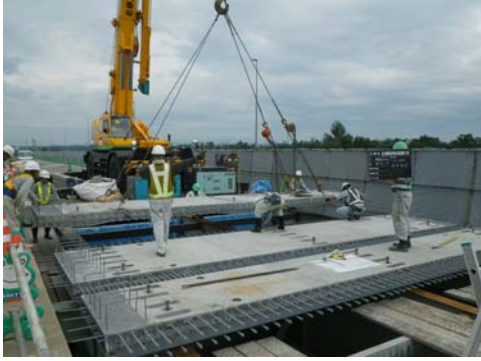
【床版設置状況】
