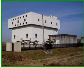
▲三本木排水機場全景(大崎市三本木地内:鳴瀬川水系多田川) 【昭和58年竣工】
