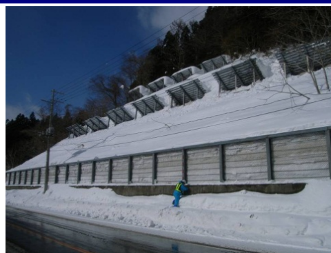
雪崩防止柵設置
