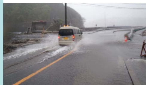
釜石市両石地区 国道45号の冠水状況
