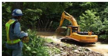
遠隔操縦による 無人化施工
