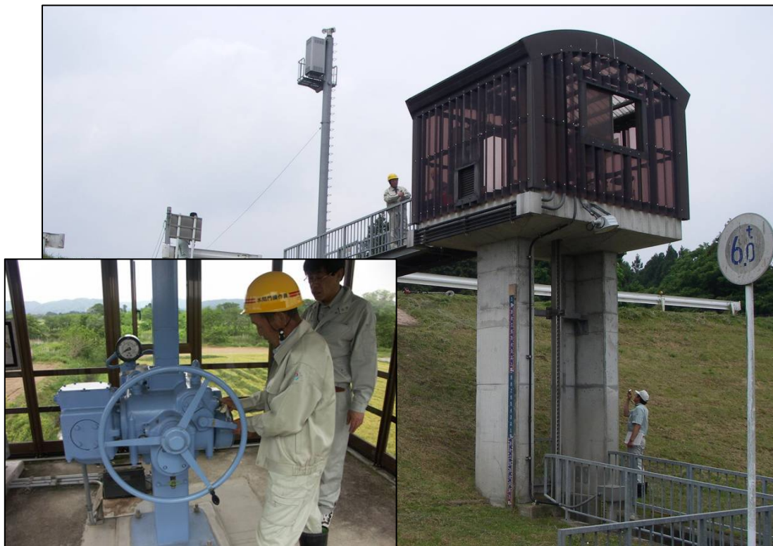
○点検している様子
