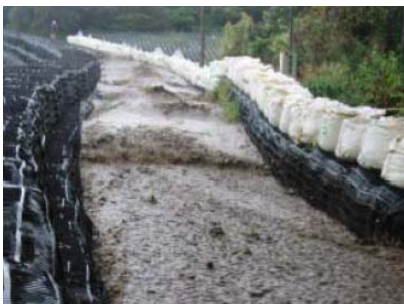
大型土嚢を配置した仮導流堤（三宅島）
