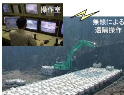
遠隔操作による堰堤施工（三宅島）
