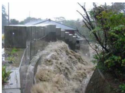
コンクリートブロックで嵩上げ（三宅島）
