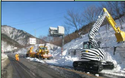
バックホウによる除去状況
