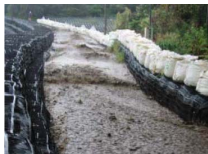
大型土嚢を配置した仮導流堤を流れる泥流（三宅島）
