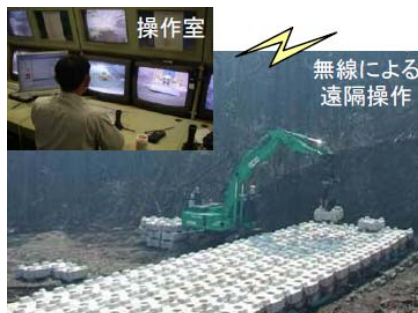
無線による遠隔操作 遠隔操作による堰堤施工（三宅島）
