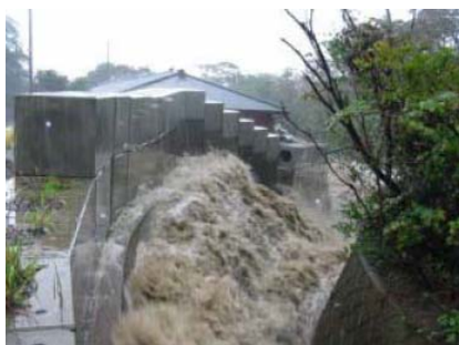
コンクリートブロックで嵩上げした流路を流れる泥流（三宅島）
