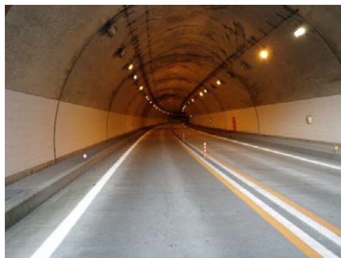
▲簡易中央分離帯設置状況 (トンネル部)
