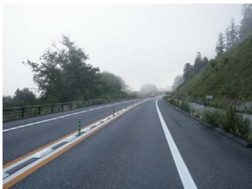
▲簡易中央分離帯設置状況 (一般部)
