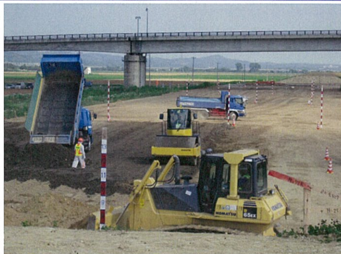
◎堤防工事（平泉町長島地区）
