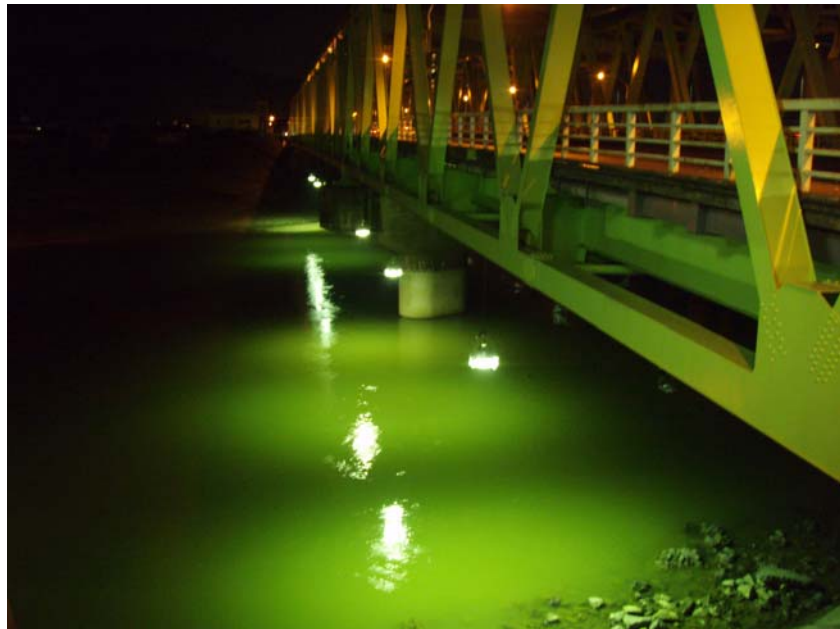
写真：国道4号 大仏橋（福島市舟場町）
