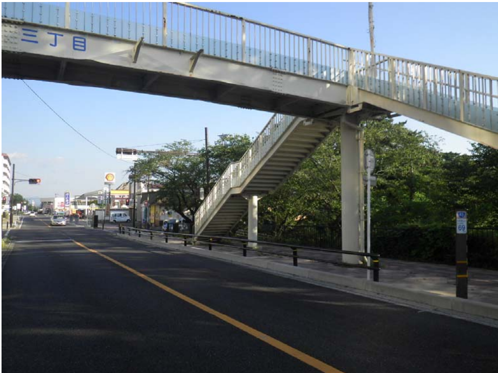
写真② 五百淵公園交差点（下り線・終点側から）
