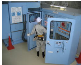
機械設備の点検
