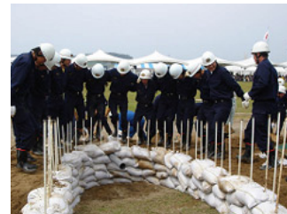
水防工法(月の輪工)の訓練
