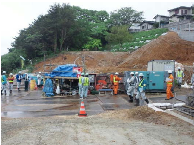
▲安全パトロール状況 工事現場に問題点等がないか点検します。
