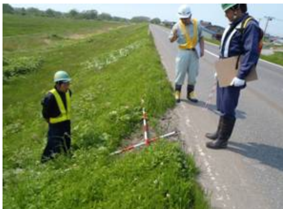
堤防の目視点検状況
