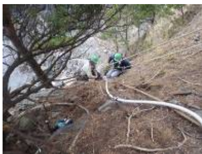
陸上ケーブル敷設状況
