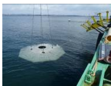
海象計架台設置状況
