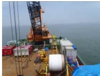
海上ケーブル敷設状況 (船上)
