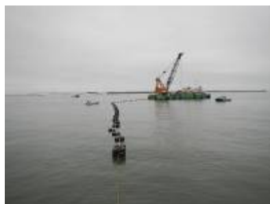
海上ケーブル敷設状況
