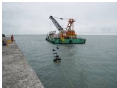
海上ケーブル敷設状況
