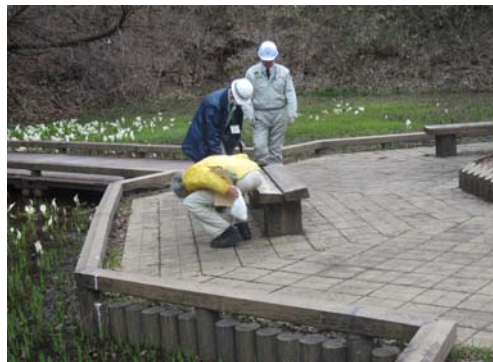
尾入野湿性植物園：点検状況
