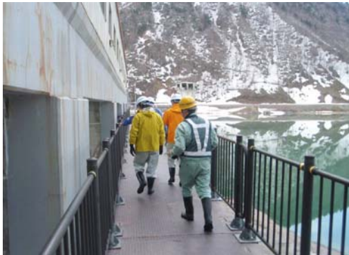
堤体管理橋：点検状況
