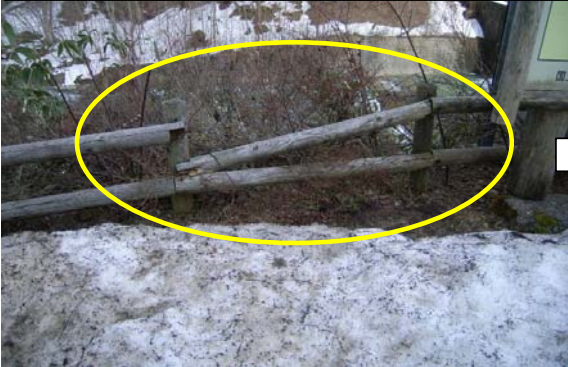
松川第1砂防えん堤（公園） 公園の木製手摺りに損傷がみられた。 （4/24応急措置済み（損傷箇所を添え木・番線で固定））
