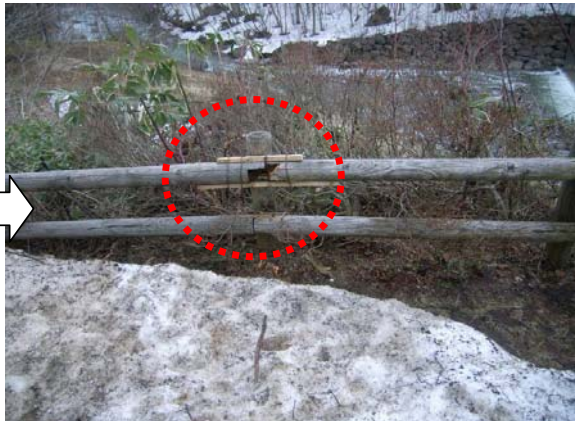
松川第1砂防えん堤（公園） 公園の木製手摺りに損傷がみられた。 （4/24応急措置済み（損傷箇所を添え木・番線で固定））
