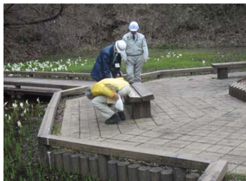
尾入野湿性植物園：点検状況
