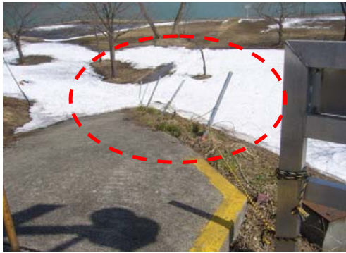
川尻公園坂路：積雪の影響により誘導柵の支柱の倒れ、ロープのたわみがあった為、再設置した。
