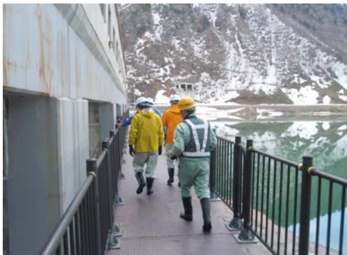
堤体管理橋：点検状況
