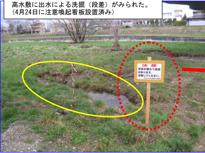
水沢水辺プラザ 遊歩道脇に出水による洗掘がみられた。 （4月23日に埋戻しを実施）
