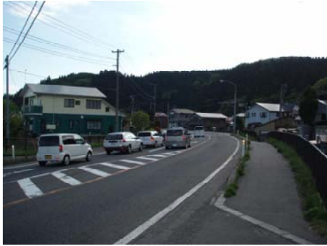
急カーブ区間に交差点があり交通事故が多発している
