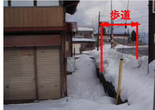
歩道が狭く、歩道除雪車が通行できないため、歩道除雪が充分に出来ない
