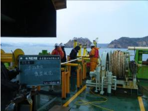
新ケーブル敷設状況
