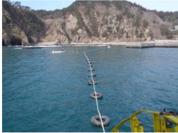
新ケーブル敷設状況
