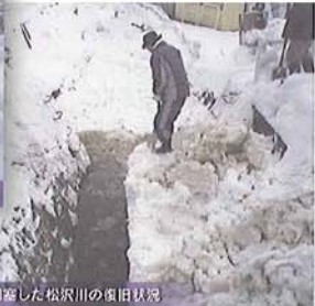
排雪により閉塞した松沢川の復旧状況
