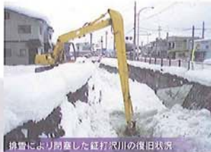
排雪により閉塞した鉦打沢川の復旧状況
