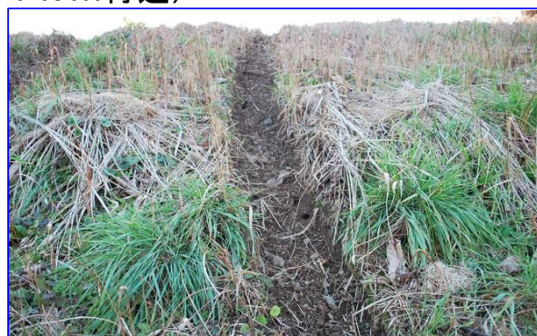
轍掘れによる大きく損傷
