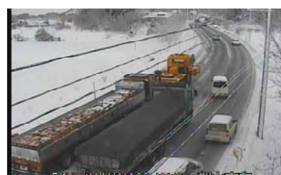
除雪車による登坂不能車の排除状況
