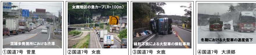
(参考)国道7号の状況写真です
