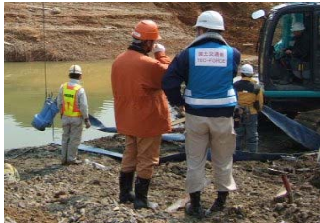
南三陸町での活動状況 (排水ポンプ車の現地調整)
