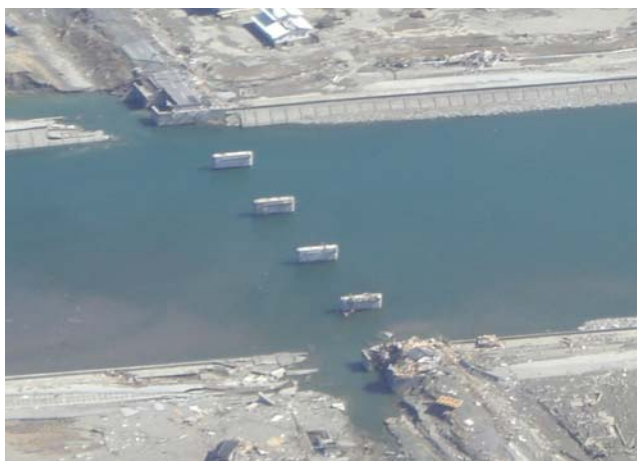
津波により流出した気仙大橋 (ヘリによる調査結果を情報提供)
