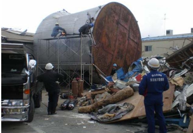
山田町での活動状況 (タンク撤去の現地調整)
