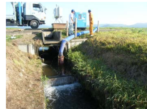
ポンプアップの状況
