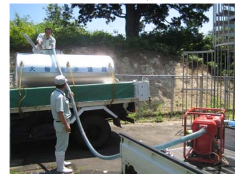
配水池への補給状況
