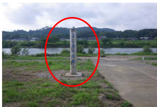
看板柱を修復した。
