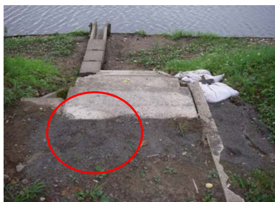
土砂の埋め戻しを行った。
