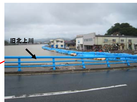
④石巻市八幡町での大型土のう積み ※ 6月26日撮影
