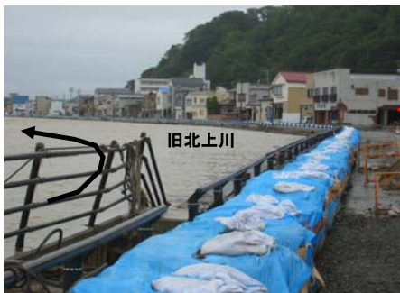
②石巻市中央～門脇町での大型土のう積み ※ 6月26日撮影
