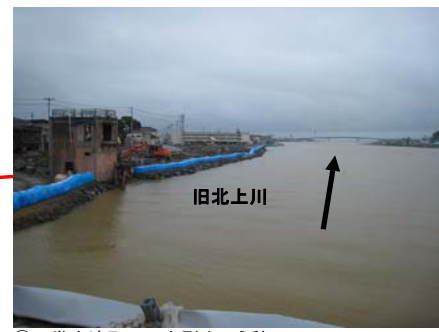
⑤石巻市湊町での大型土のう積み ※ 6月26日撮影
