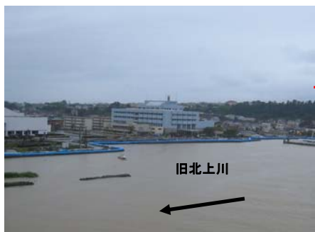
③石巻市門脇町での大型土のう積み ※ 6月26日撮影
