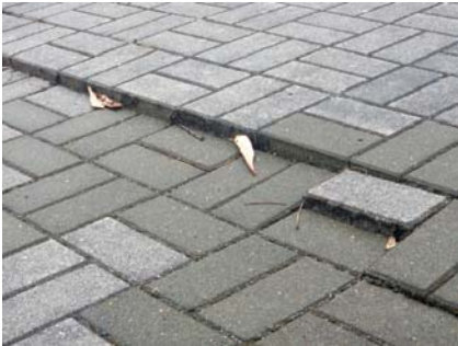
向田瀬地区ヨットハーバー：インターロッキングブロックに生じた段差(占有者により4/29までに措置の予定)
