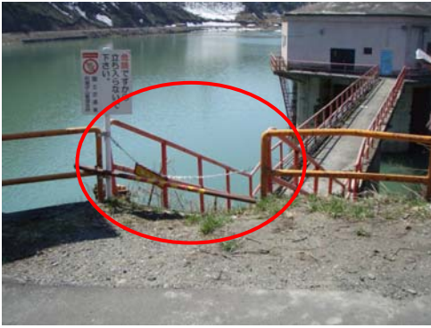
石淵ダムダムサイト：取水塔入り口の立入り禁止箇所へのチェーン等立入り禁止再設置
