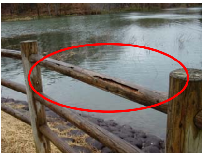
松園散策路：散策路脇の間伐材を使用した転落防止策に腐食等がある事から、4/25までに 応急処置の予定
