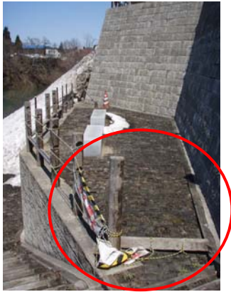
湯本湖岸公園：積雪の影響により破損した支柱立入り禁止措置の再設置
