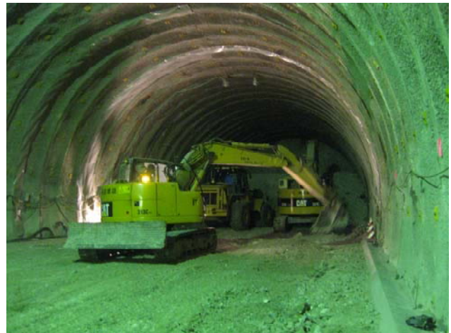
写真-2 掘削に向けての準備作業状況
