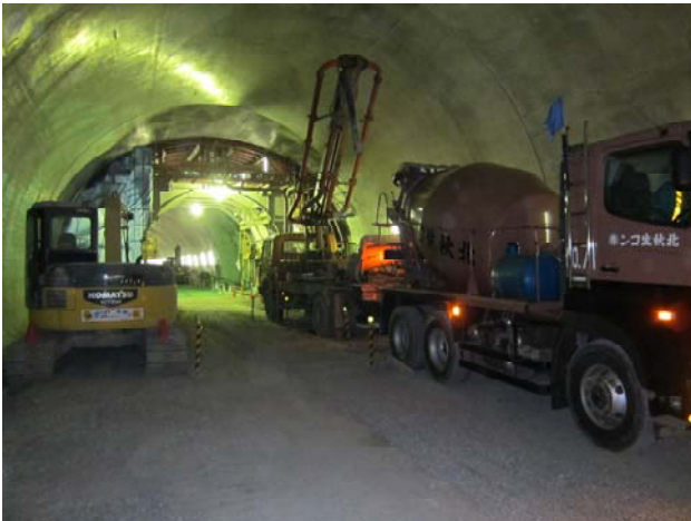
写真-1 覆工へのコンクリート打設状況
