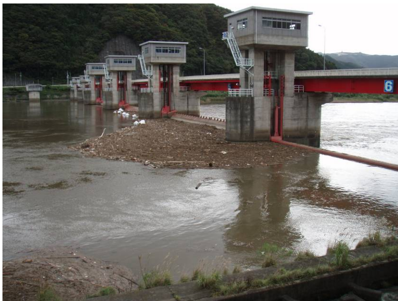
流木堆積状況
