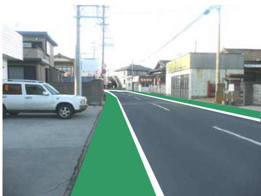
<車道の幅を片側約 50cm 程度狭めて、歩行者の通行帯を設置(緑色のカラー舗装)>
