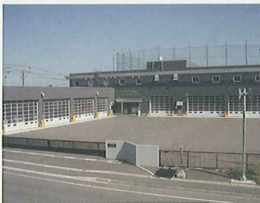
八戸防災ステーション全景
