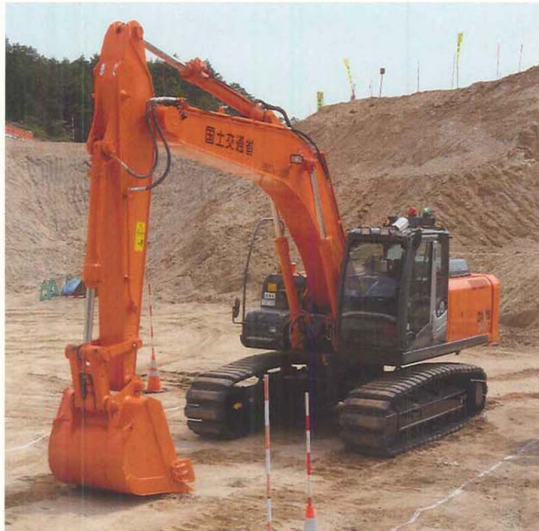
写真-1 遠隔操縦式油圧ショベル(1.0m³)全景
