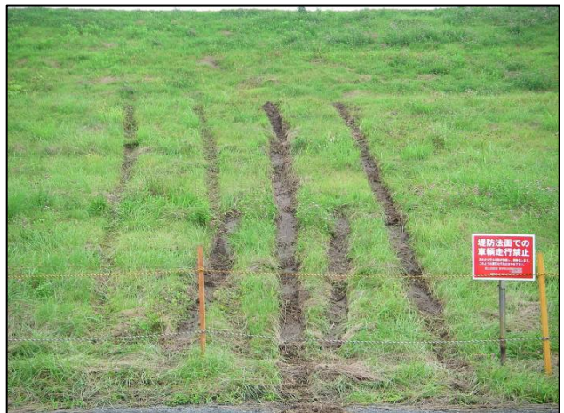
堤外 -2(堤外から天端)
