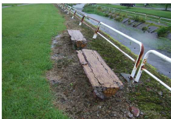
ベンチが破損していた。(大仙市:中川原河川公園)
