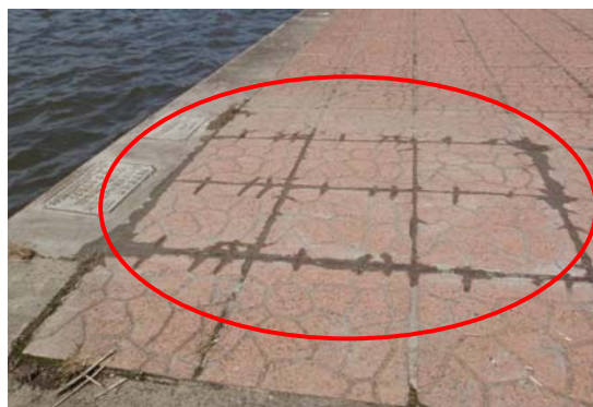
地盤を整正しブロックを再設置した。
