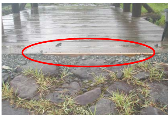
止め板並びに砂利の敷き詰めを行った。
