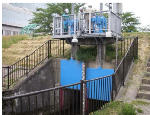
【施設点検の様子】
