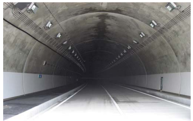
完成した「いわき三和トンネル」の内空
