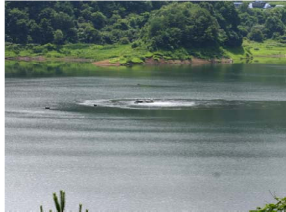
水質保全施設の稼働状況（7月6日）
