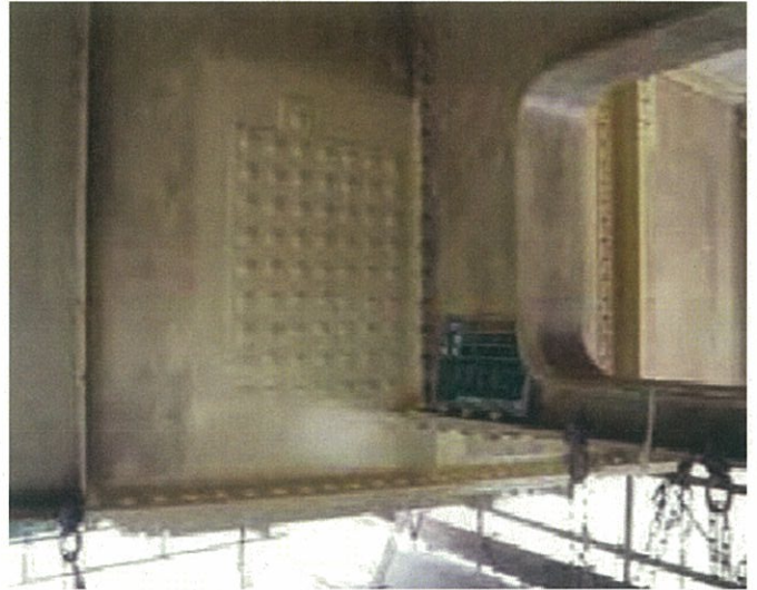
当て板工法による補修事例
