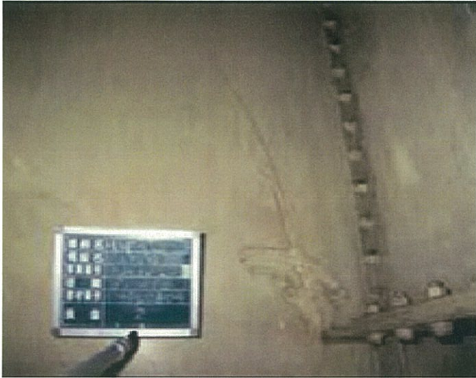
主桁の亀裂
