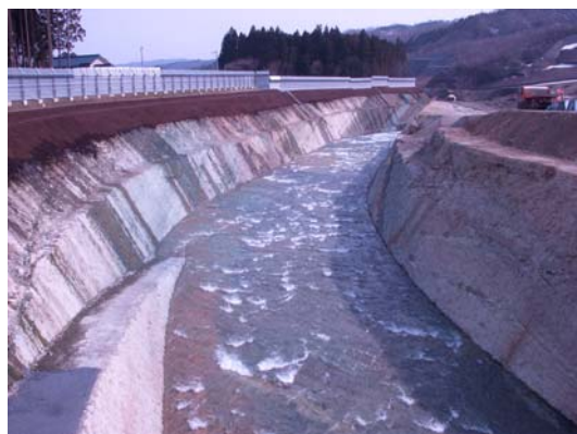
河道掘削状況です
