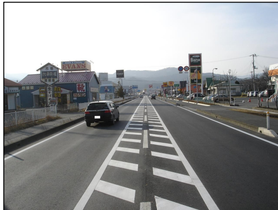
沿道への流出車両への追突を回避するための待避ゾーンの設置 (陸前高田市気仙町字曲松)
