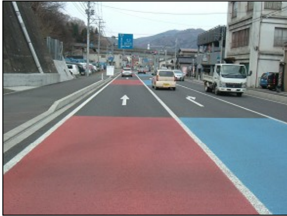
交差点での追突を注意喚起するカラ・舗装 (釜石市松原町3丁目)
