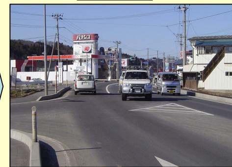
右折車線により後続車がスムーズに走行
