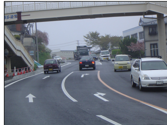
右折車への追突を回避するための右折レーンの設置 (宮古市日の出町)
