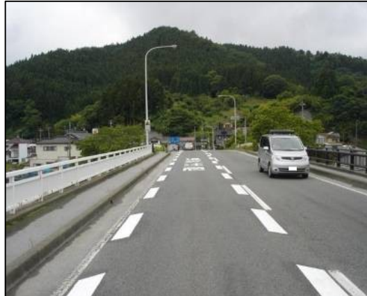
走行速度の抑制を促すドットライン (陸前高田市気仙町字的場)
