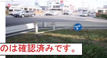
道路標識の損傷
