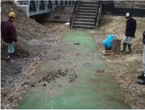
石淵ダムダムサイト：通路の土砂撤去及び立入り禁止箇所への注意喚起看板設置
