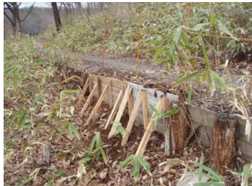
松園散策路：散策路脇の土留めが腐食し崩れていたことから、補修を行った
