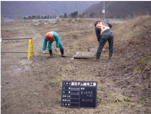
錦秋湖大石公園：柵蓋の補修状況
