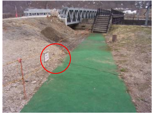
石淵ダムダムサイト：通路の土砂撤去及び立入り禁止箇所への注意喚起看板設置
