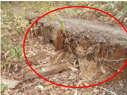
松園散策路：散策路脇の土留めが腐食し崩れていたことから、補修を行った
