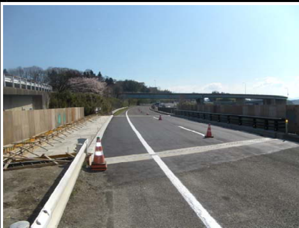
羽石川橋全景
