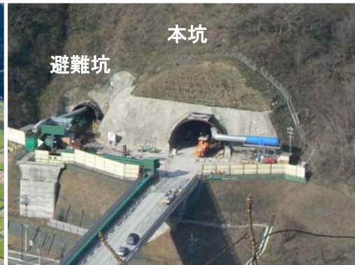
▲温海トンネル L=6,022m (H22.3月末 掘進約5,588m)
