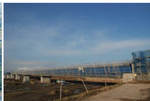
▲庄内中央大橋(仮称)の 上部工架設状況
