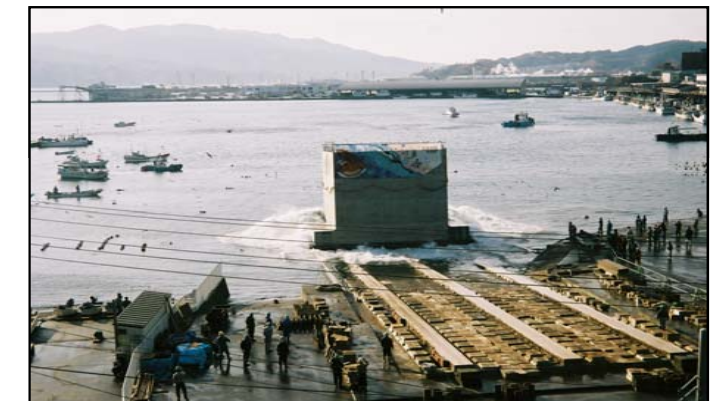
〈陸上の函台部で製作されたケーソンは、海上に向けて敷設されたレールの上を自重落下で進水される〉
