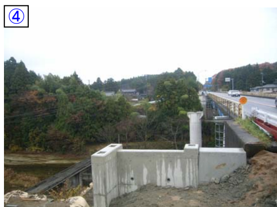
井出川側道橋
