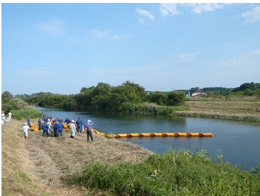
オイルフェンスの設置
