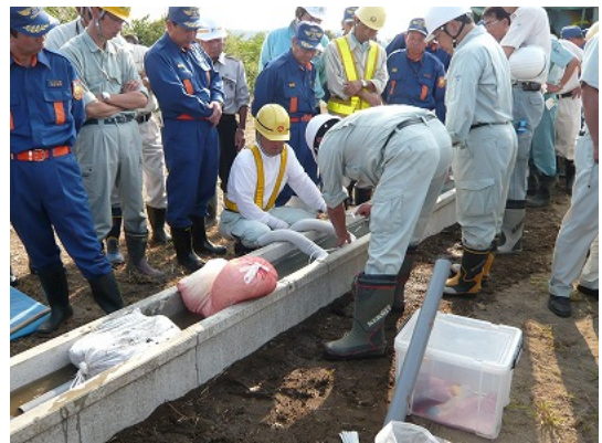
側溝での流出防止
